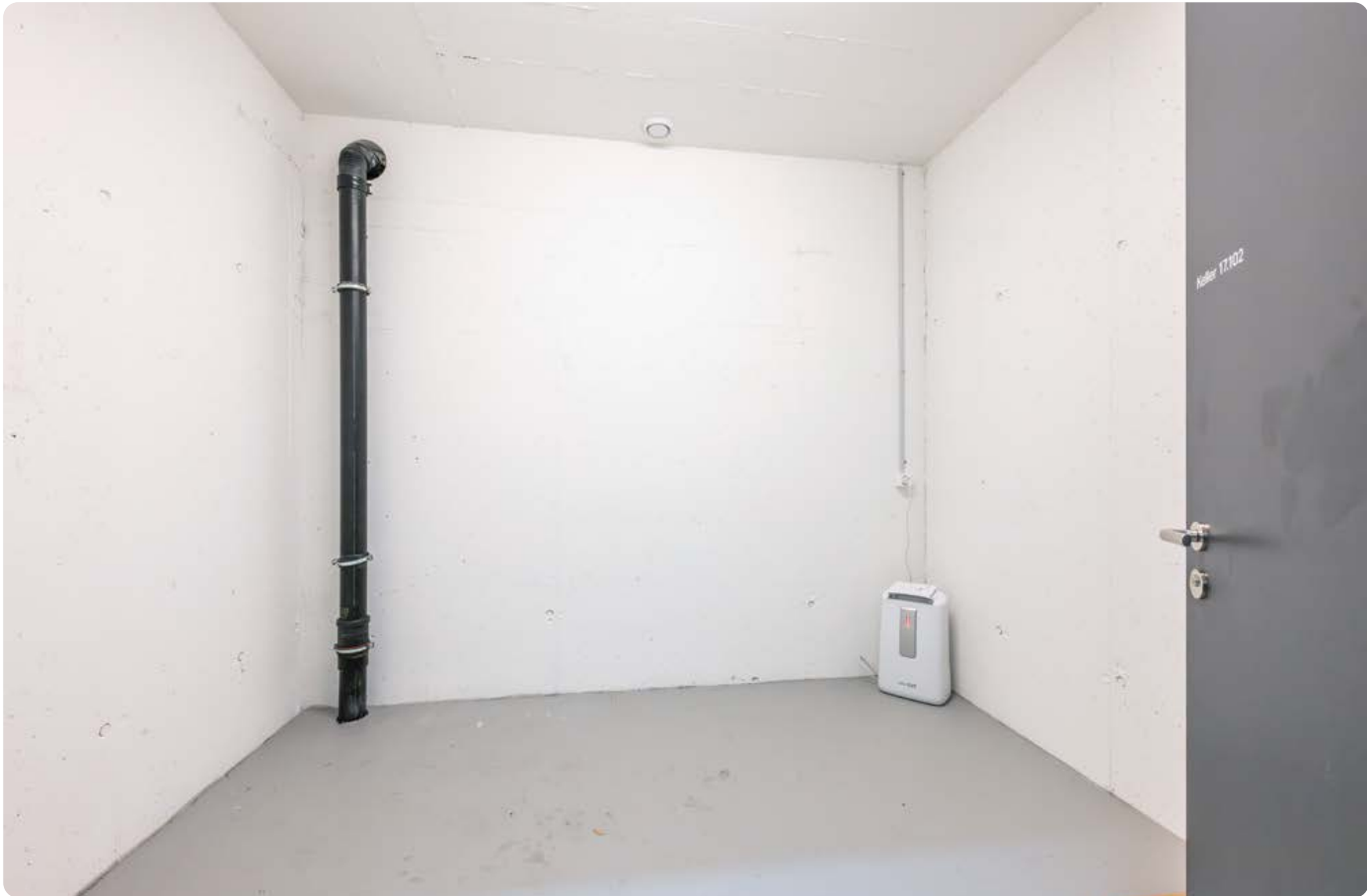
Keller im 2. Untergeschoss
