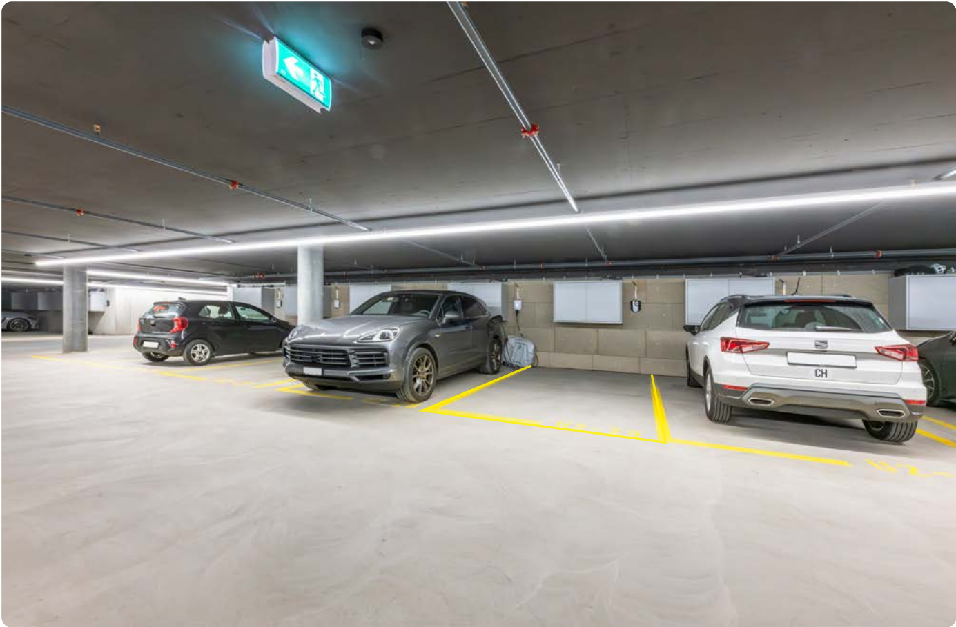
Tiefgaragenparkplatz Nr. U2-29 mit E-Auto-Ladestation und Reifenschrank
