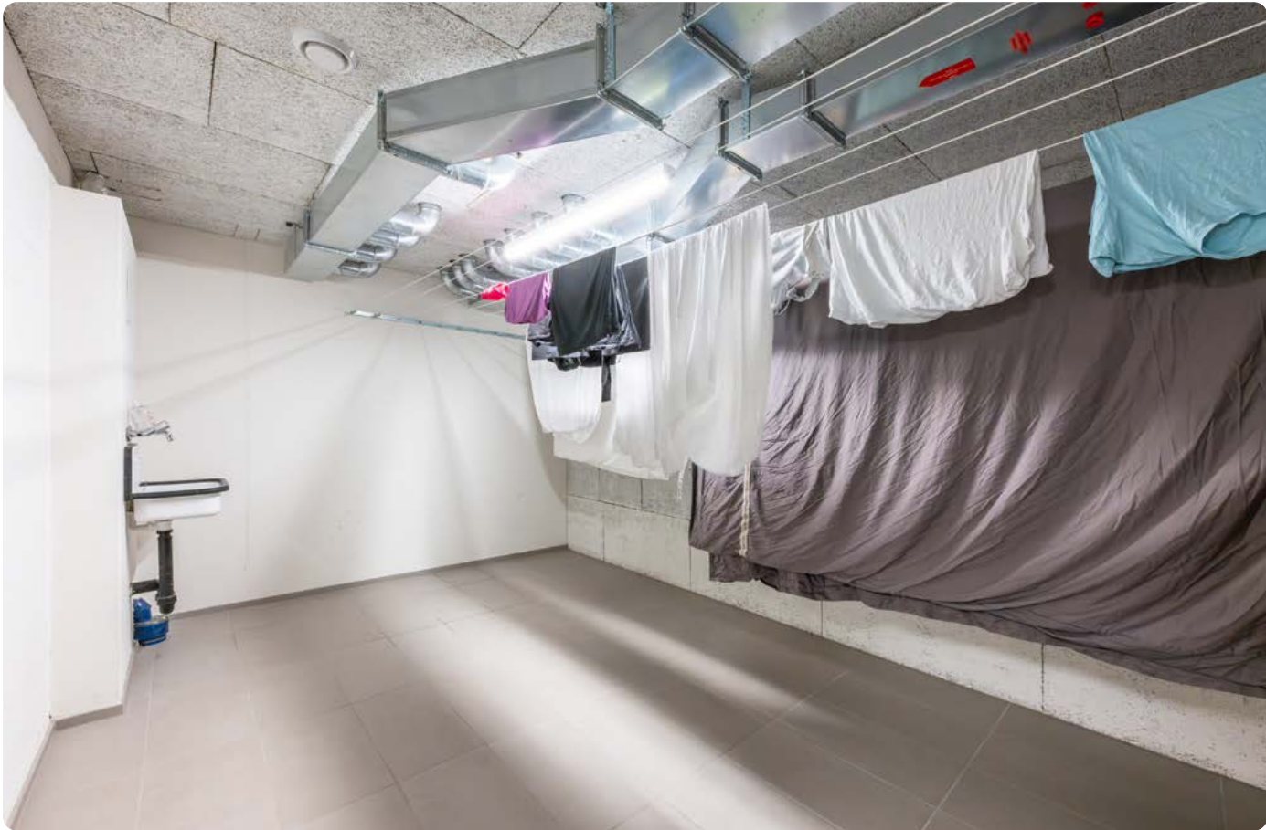
Trockenraum zur Mitbenützung
