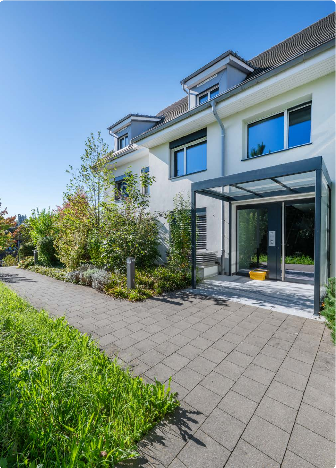
Haupteingangsbereich Wangenstrasse 2d
